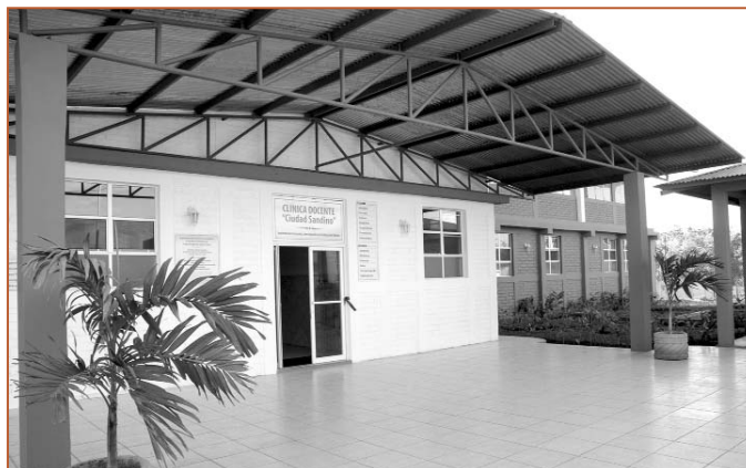
Vista de uno de los edificios de la Unidad Clínico
